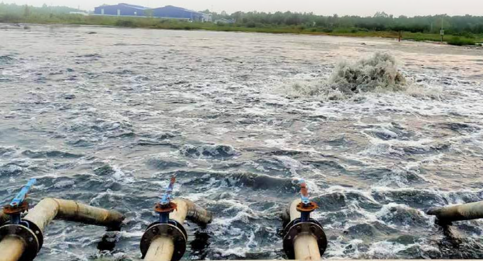
Hệ thống xử lý nước thải tại Nhà máy Tapiotek
